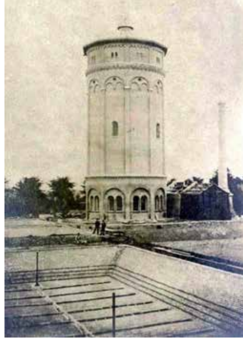
Bouw watertoren en aanleg filterbakken 1883
