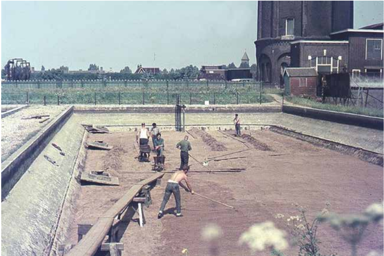
Het openharken van de filters en het verwijderen van de toplaag
