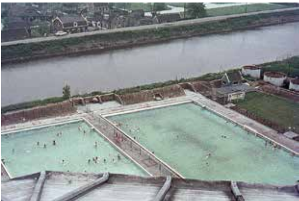
Het Torenbad vanaf de watertoren. Zwemmen in de oude filters, ± 1975 (archief Oasen)
