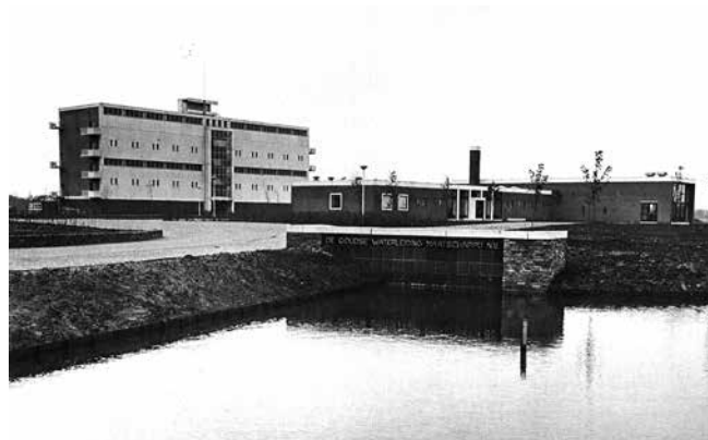
Pompstation C. Rodenhuis (Bergambacht) na de opening in 1968. Het tweede gebouw werd kort na 1970 gebouwd (archief Oasen)
