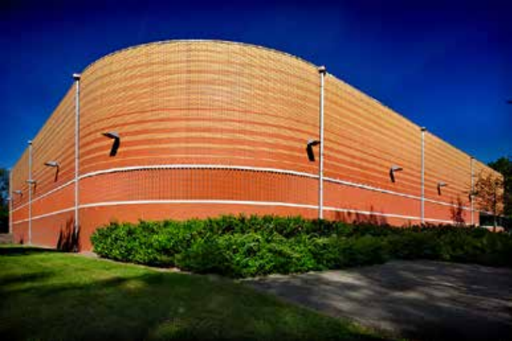
Suppletiepompstation Gouda (foto DigiDaan)
